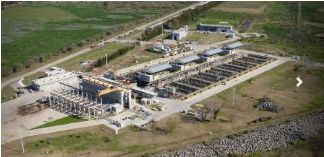
Planta Depuradora de Líquidos Cloacales del Bicentenario
